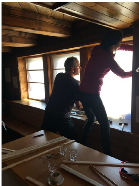
Ausbau Fenster und Abdeckung mit Folie
