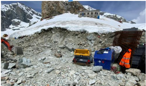
Start Bauarbeiten Mai 2023
